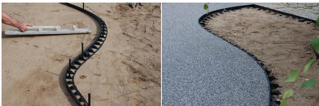
Slika: Postavljanje plastičnih ivičnjaka
